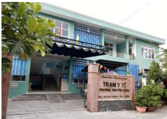
Trạm Y tế Hòa Thọ Đông
