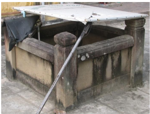
Giếng vuông tại Nghĩa Trưng Khuê Trung, quận Cẩm Lệ (Ảnh: St)
