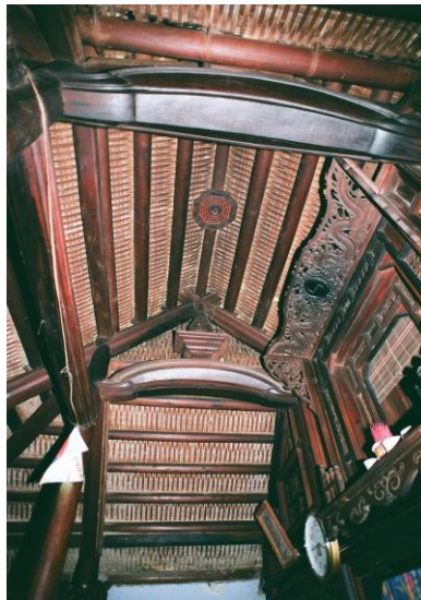
Vì kèo phía nóc có dáng phình ra trông như cái vòm, trần đan Bằng tre. Nhà cụ Trần Hiệp tại thị xã Sông Cầu (Ảnh: Nguyễn Thượng Hỷ, 2007)
