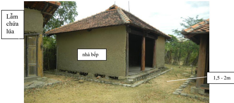
Nhà bếp, cánh ngôi nhà chính 1,5m-2m
