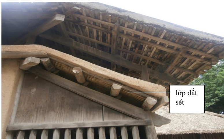
Thang Lâm của người Chăm là nhà có hai mái, mái dưới đắp một lớp đất sét
