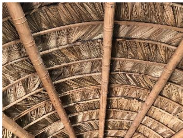
Bố trí cây đà phần nóc và phần mái nhà
