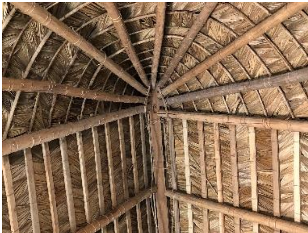
Bố trí cây đà phần nóc và phần mái nhà
